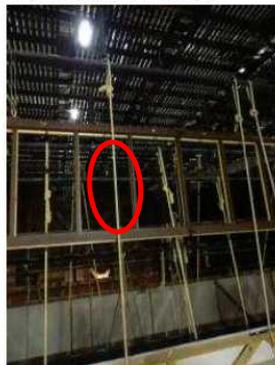
放送設備の取付部分・舞台装置の落下防止対策の例
