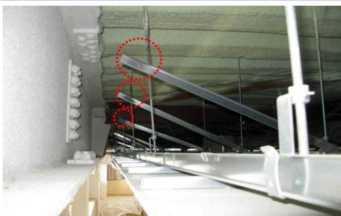
斜め部材の溶接が外れた被害
