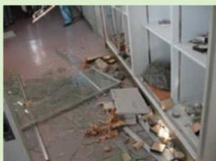
(写真1) 収納物の飛び出しとガラスの飛散
