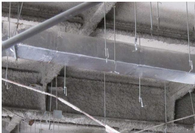
ハンガーの開きにより天井が脱落した例
