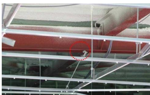
写真2: H形鋼梁への吊り金具が外れた被害
