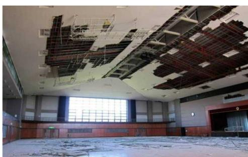
写真1: 天井の中央部分での脱落
