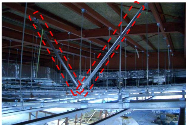
斜め部材のV字状配置の例
