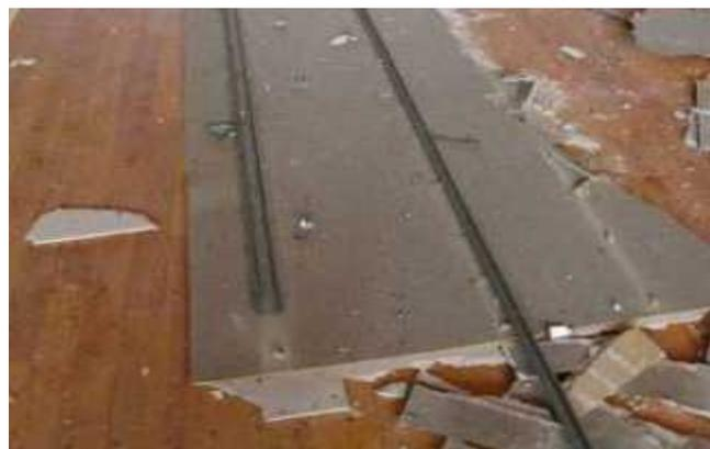
クリップの外れにより床面に落下した天井の例
