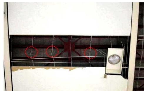
写真3: 野縁受けの接合箇所(金具接合)の外れ
