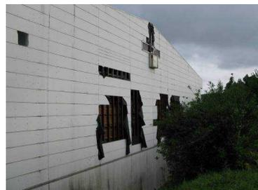
外装材(セメント系)の損傷
