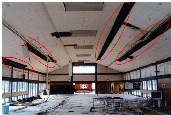
天井と壁との間、折れ曲がり部分等の脱落の例
