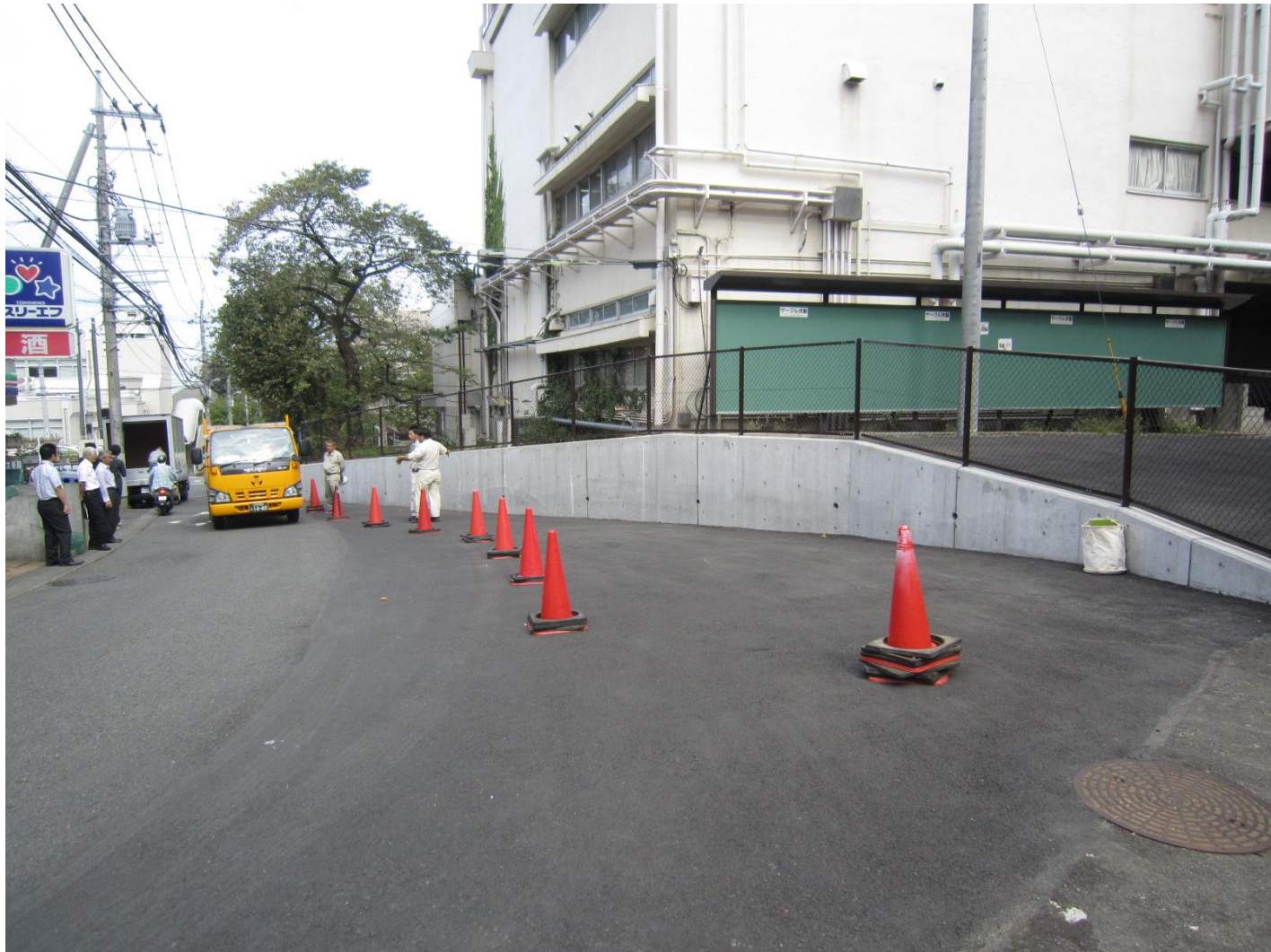
道路拡幅状況
