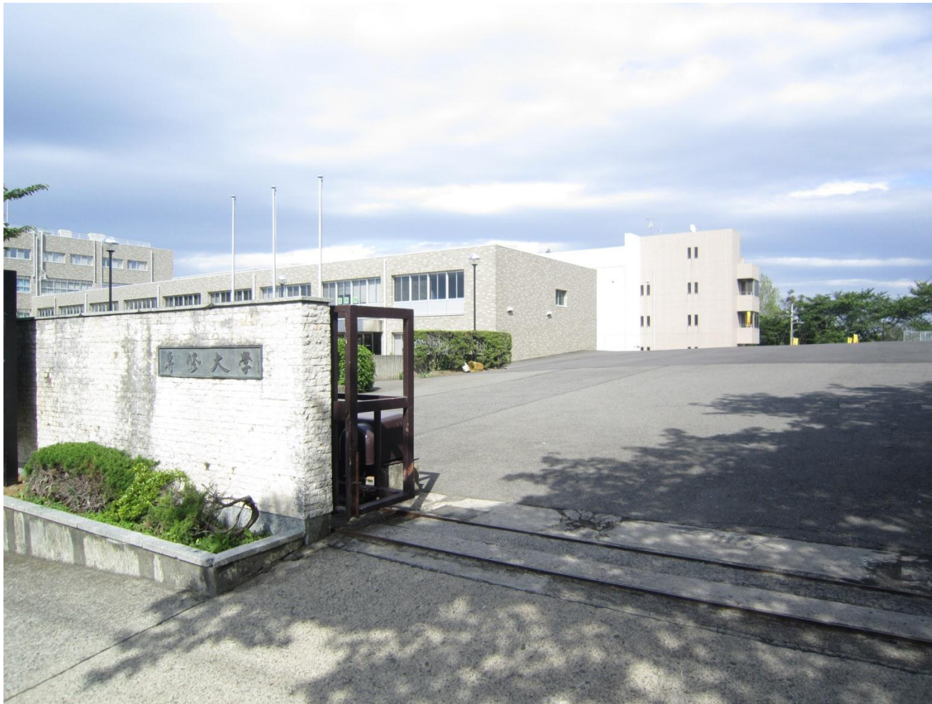
専修大学3号館 解体後
