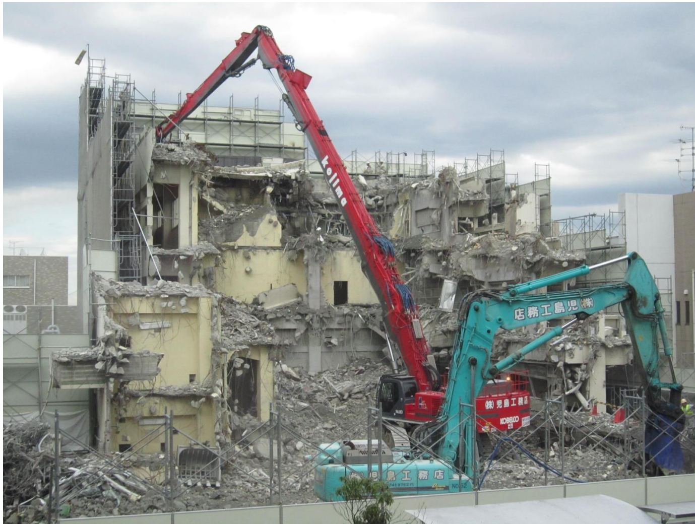
専修大学3号館 SK950での解体
