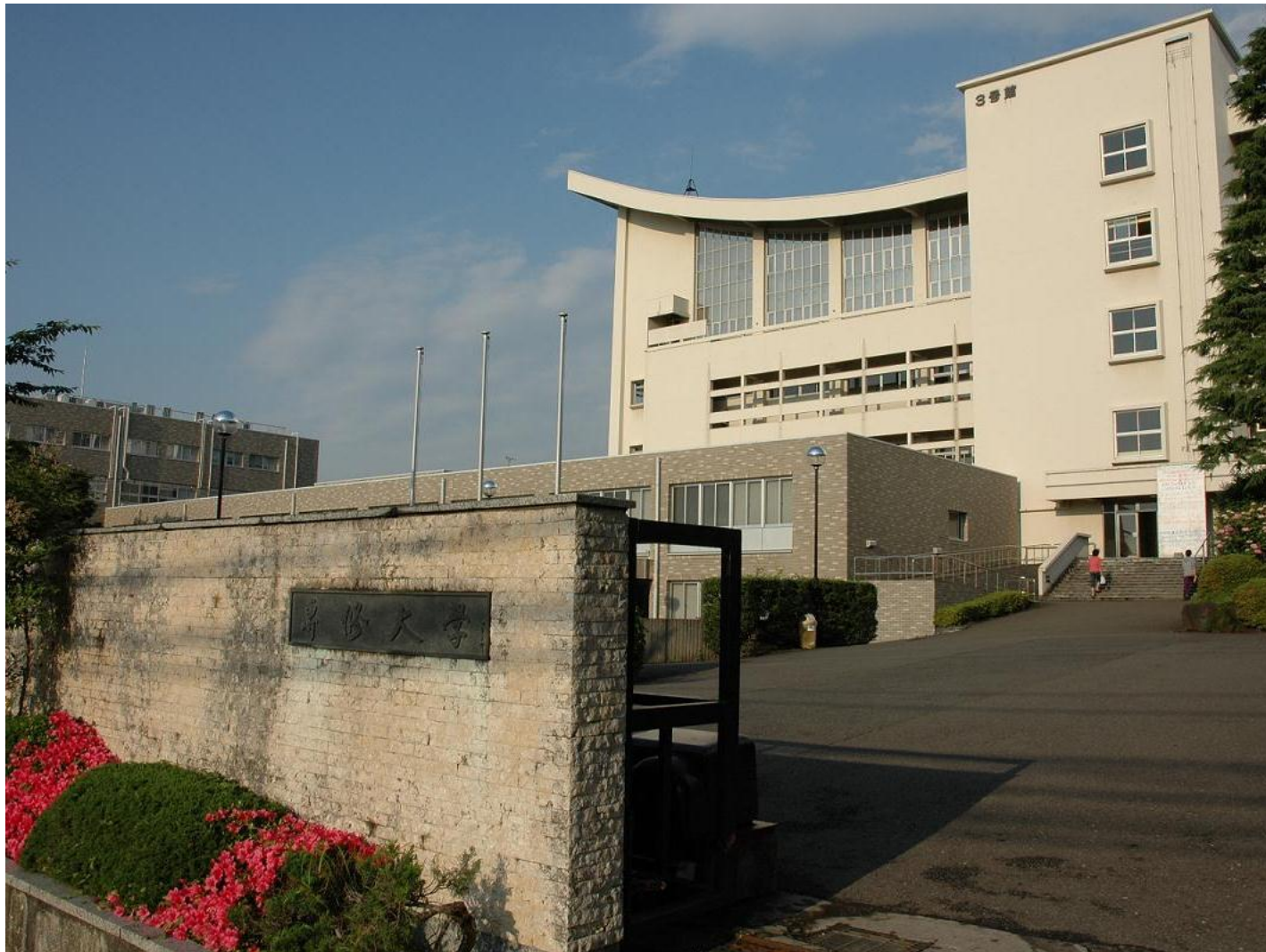
専修大学3号館 解体前
